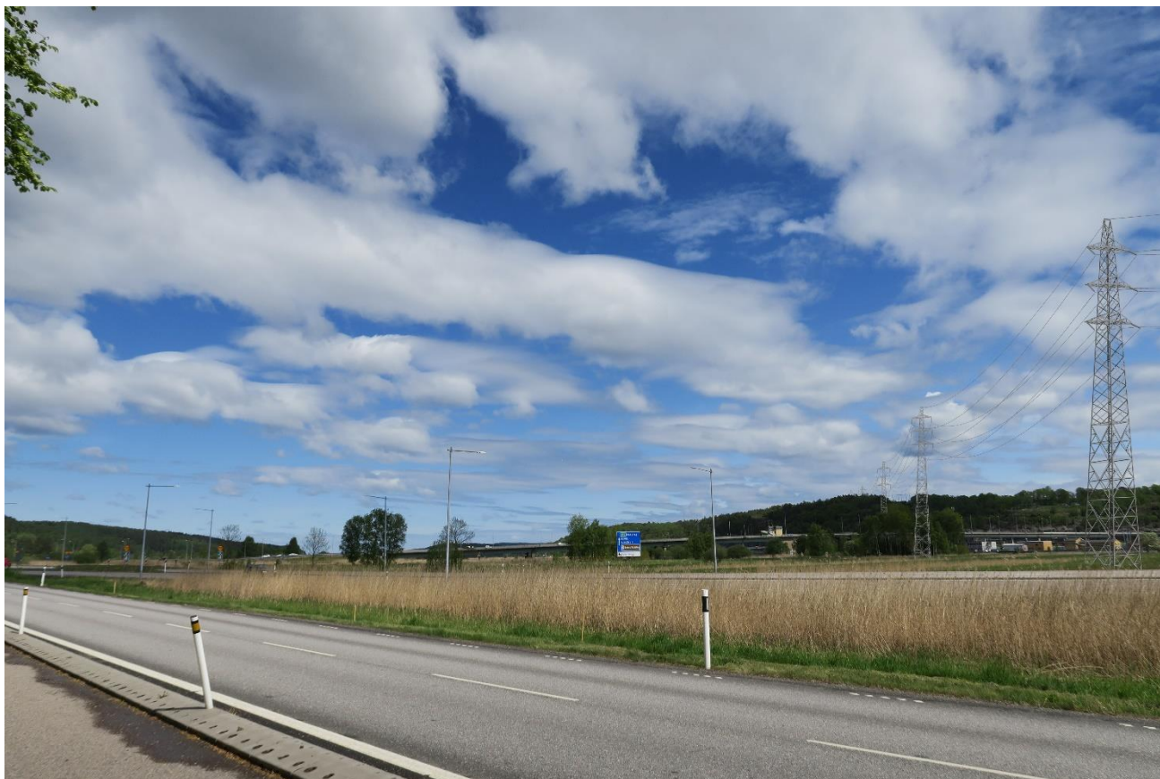
Figur 6. Visualisering av ny dubbel 130 kV-ledning. Vy från väster mot Jordfallsbron med Ellesbovägen i förgrunden, se fotopunkt 3 i Figur 3. Stolphöjd i visualiseringen är ca 55 meter. Visualisering framtagen av WSP Sverige AB.
