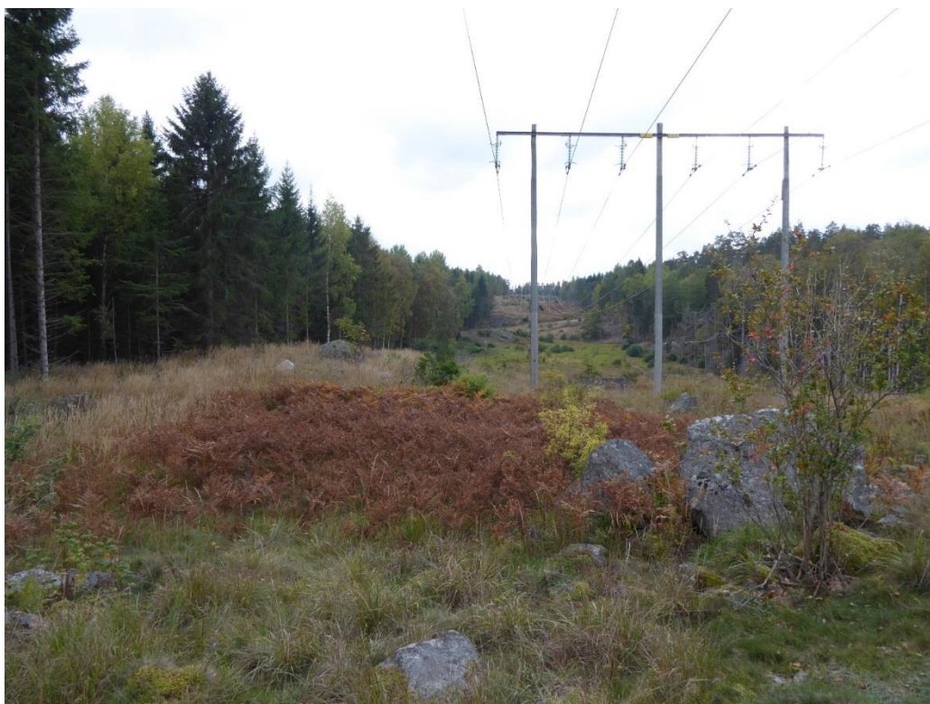
Figur 12. Ledningen där den sträcker sig parallellt med 70 kV ledningen ÄL93S1 mellan Ekensberg och Talby. Bilden är tagen mot söder.
