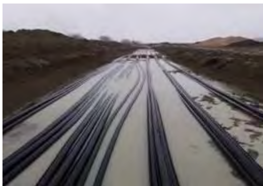
Figur 21. Exempel på 130 kV kabelschakt med sex förband.
