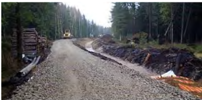
Figur 22. Exempel på arbetsväg parallellt med 130 kV kabelschakt för ett till två förband.
