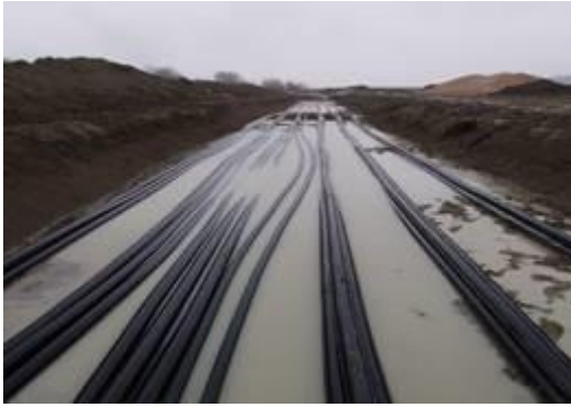
Figur 8. Exempel på 130 kV kabelschakt med sex förband.
