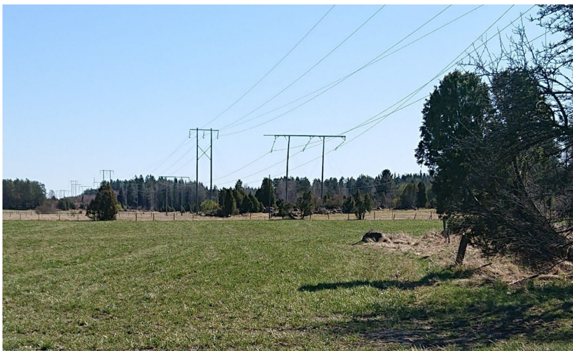
Figur 7. Svenska kraftnäts 220 kV ledning till höger och Vattenfall 70 kV till vänster
