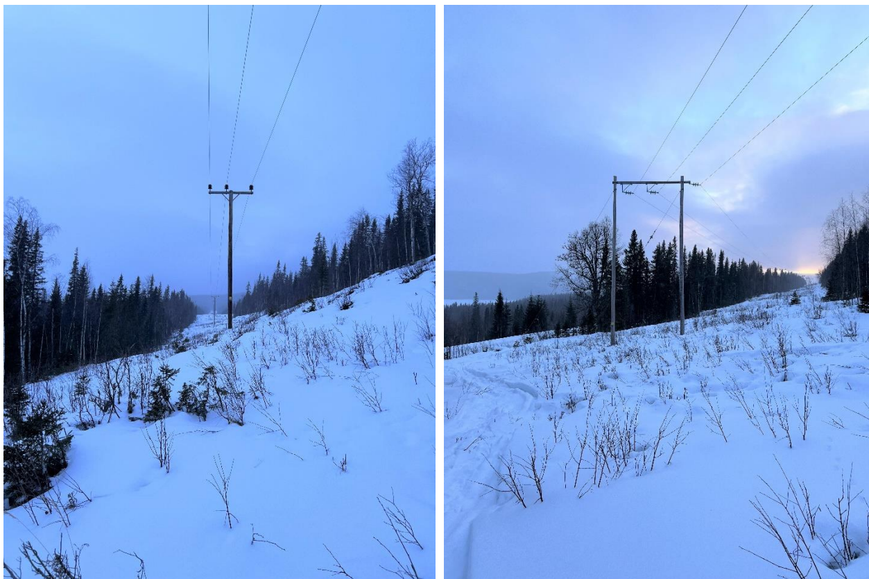
Figur 3. Exempel på enkelstolpe och parstolpe.
