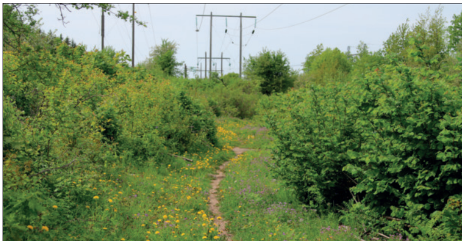
Kraftledningsgata i Motala.
